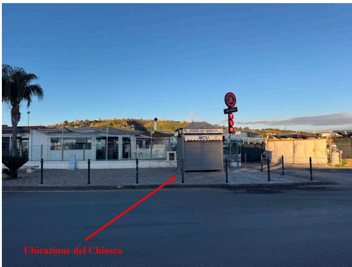
Foto 4 –Frontale lato strada
