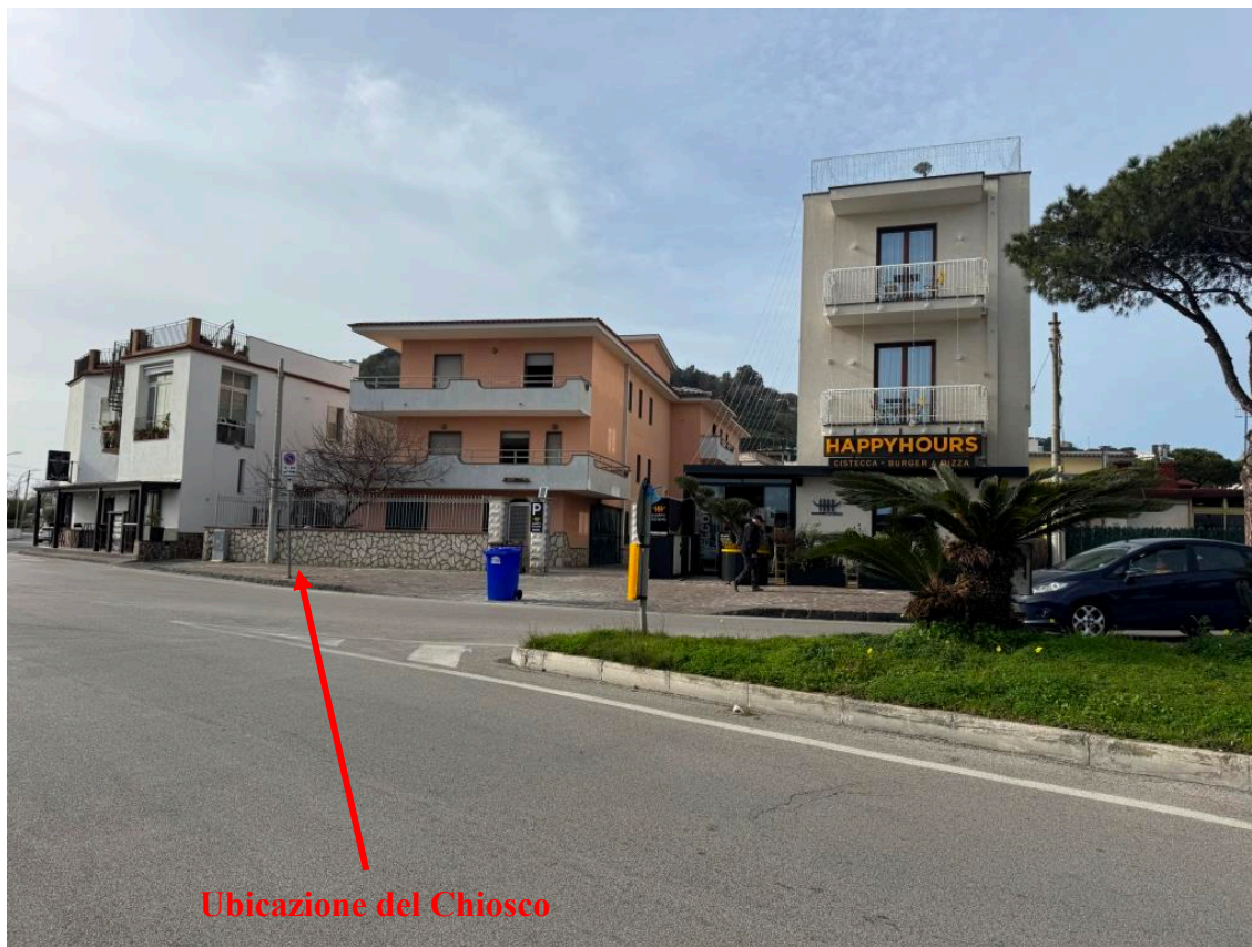
Foto 5 – Frontale lato strada
