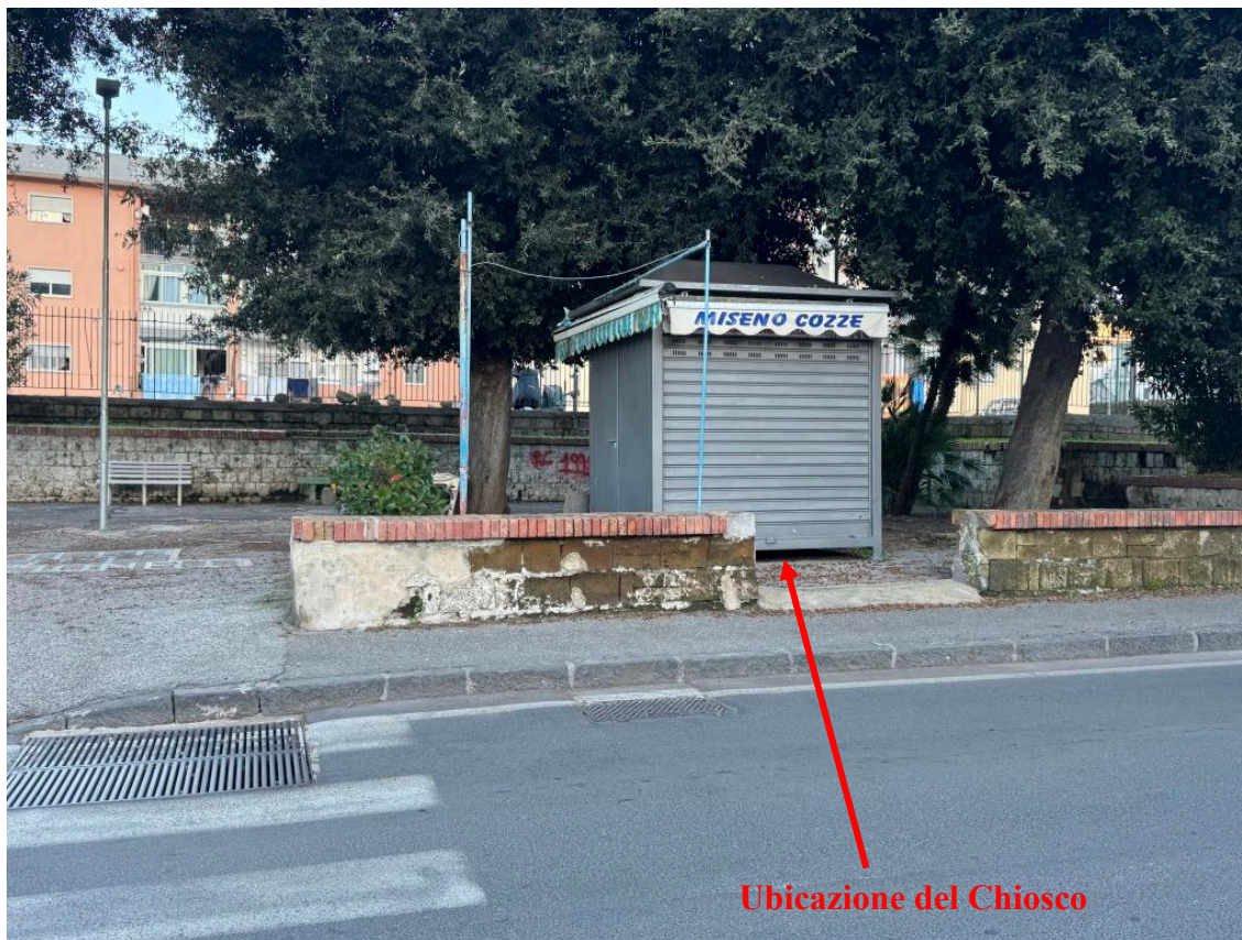
Foto 5 – Frontale lato strada
