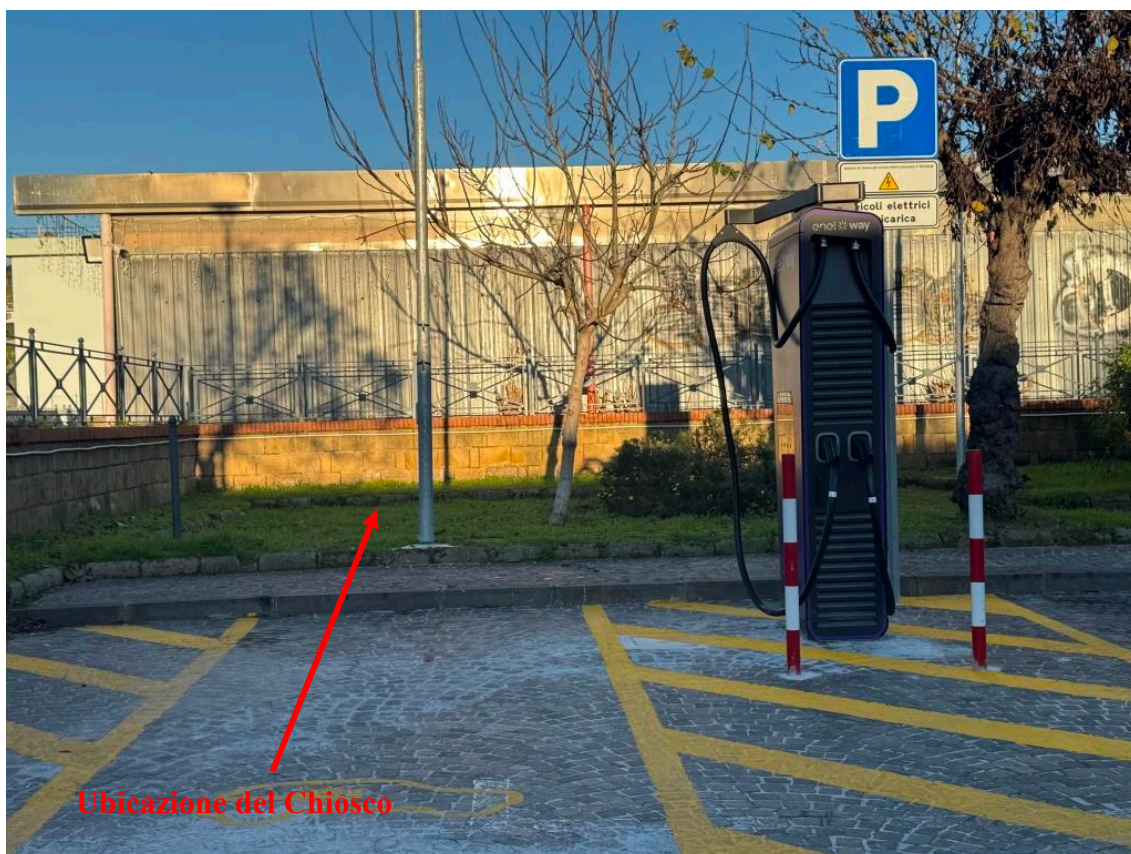
Foto 4 –Frontale lato parcheggio
