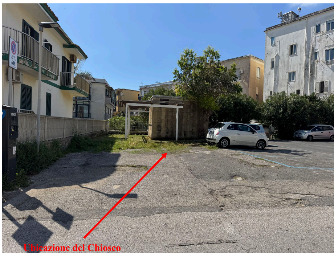
Foto 4 –Frontale lato strada
