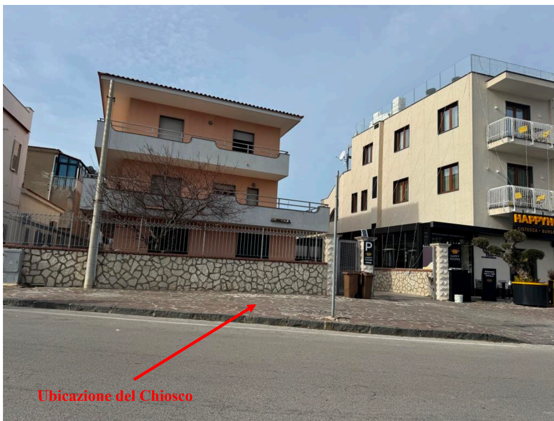
Foto 4 –Frontale lato strada
