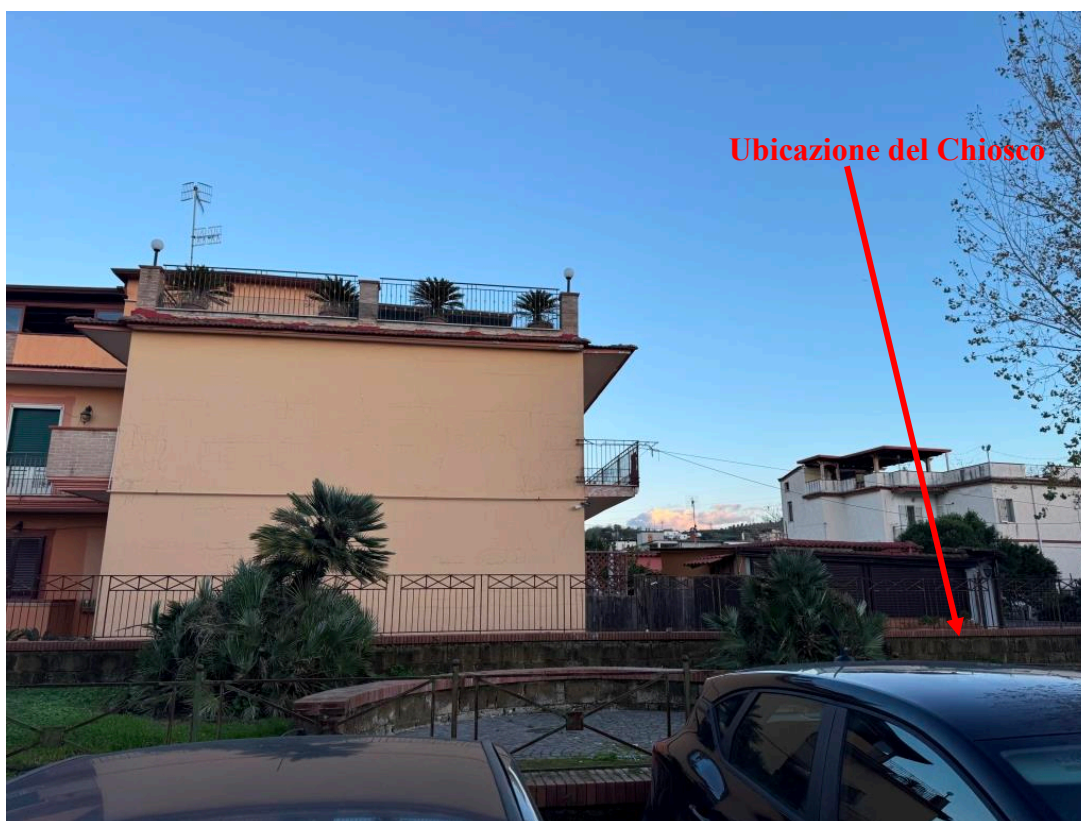
Foto 4 –Frontale lato parcheggio
