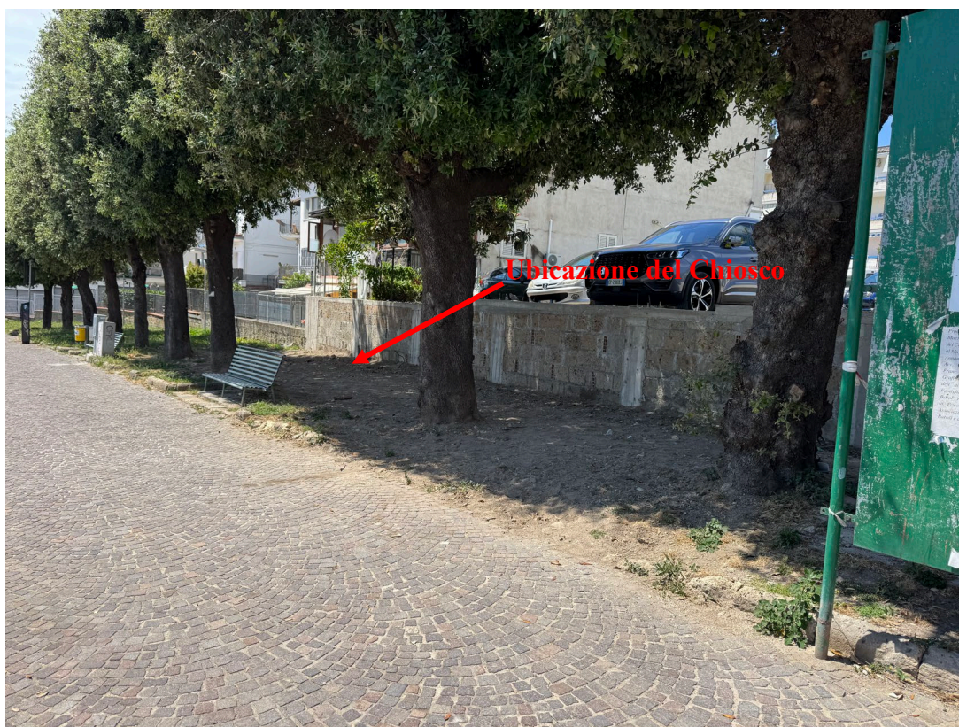
Foto 6 – Laterale lato marciapiede
